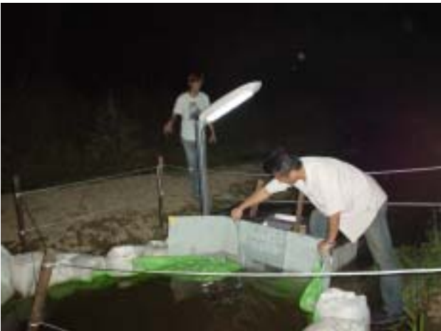
小さな堰が開けられ小水力発電が稼働、街灯が点灯！
